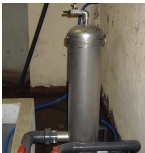
Figure 26 : Filtration stérilisante sur filtre 0,22 \mu\text{m}
