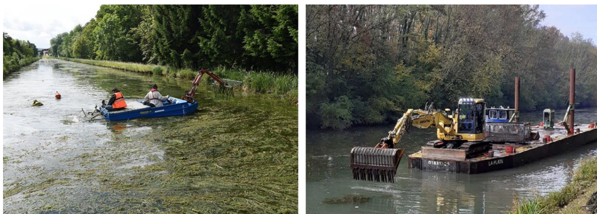
Figure 2.7. Méthode de contrôle physique de M. heterophyllum en France. A gauche, faucardeur (coupe). A droite, pelle à grand bras sur ponton flottant (arrachage). Photos : VNF.
