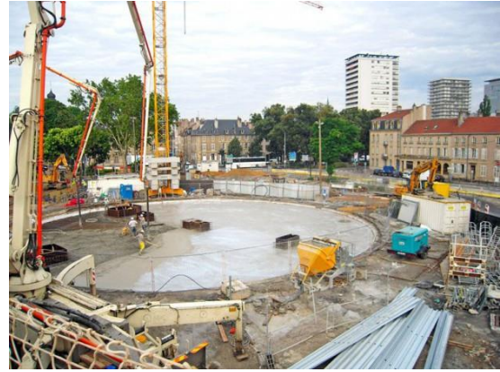
Figure 90 : Etat de la place Mazelle au moment de la construction du réservoir d'eau (2010) (source batiactu.com ).
