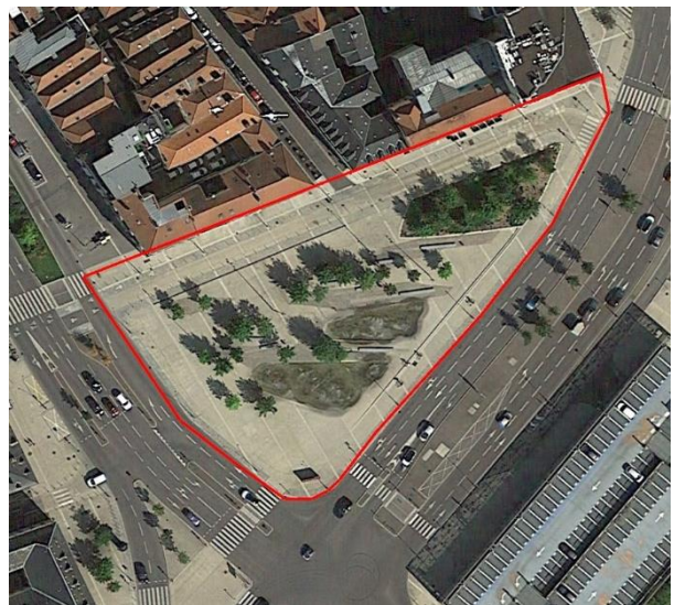
Figure 89 : Vue aérienne de la place Mazelle (source : Google Satellite ).
