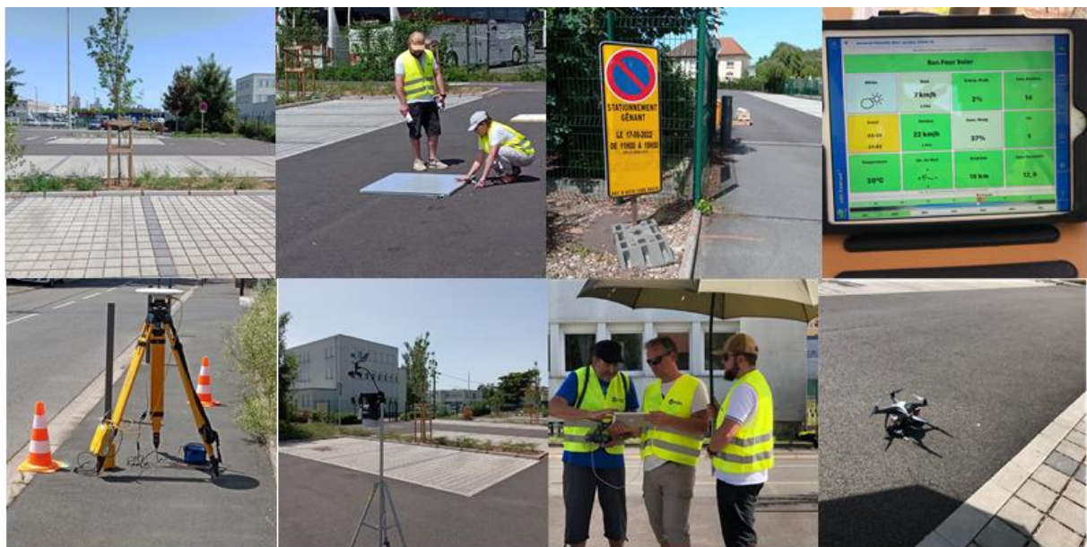
Figure 107 : Prises de vue au sol lors de la mission sur le parking de la route de Thionville après travaux (crédits photo : Gilles Drogue et l’auteur, légende des photos en Annexe 22 ).
