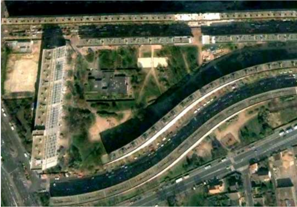
Photographie 19 : Avant la démolition de quatre barres dans le quartier du Luth à Gennevilliers afin de désenclaver le quartier 1
