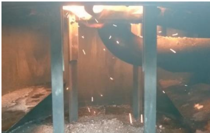
Figure 85 : Photo du brûleur lors d'un essai de combustion haute température sans recyclage.
