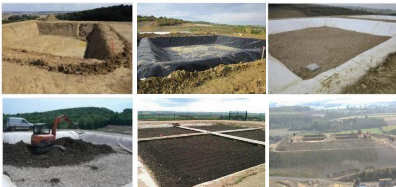
Annexe 1 : Photographies des parcelles de Jeandelaincourt en cours de construction (été 2013). Sources : www.lorver.org et thèse d'Ali Kanso (2016).
