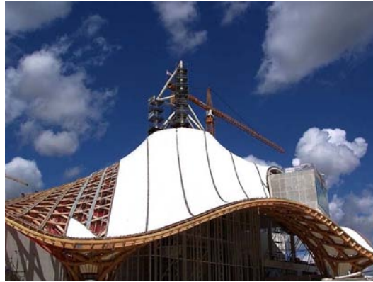
FIGURE 1.1 – Charpente et membrane du toit du Centre Pompidou à Metz pendant sa construction. L'architecture de la toiture est faite en double courbures pour permettre sa résistance face aux aléas climatiques (vent, neige, grêle,...). (source : blog Marc de Metz).
