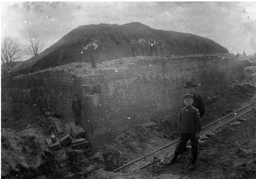
**Fig. 57** Travaux de démantèlement de la lunette d'Arçon (11 avril 1904)
