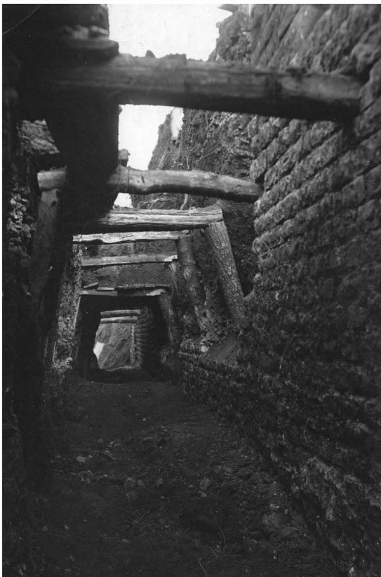
**Fig. 62** Galerie renforcée par des rondins de bois lors des fouilles de l'amphithéâtre (1903)
