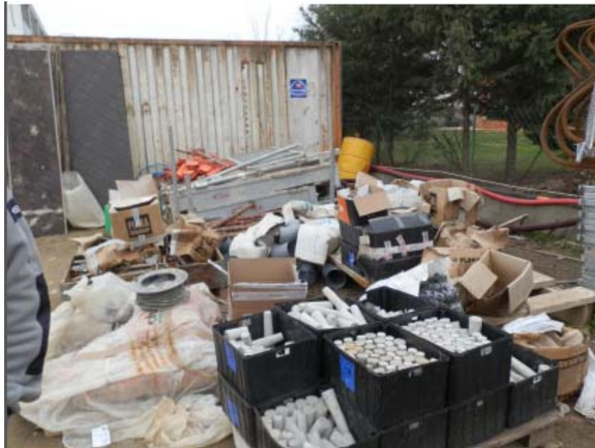
Figure 18 : Zone de stockage sur un chantier
