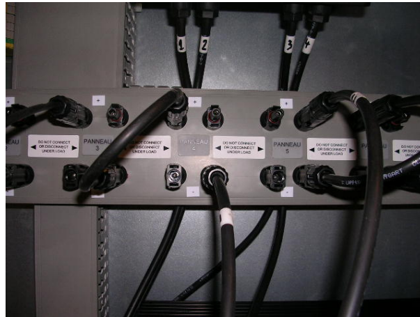
FIGURE 5.35 – Photo d’une partie du bornier de raccordement individuel du champ de panneaux Ouest.
