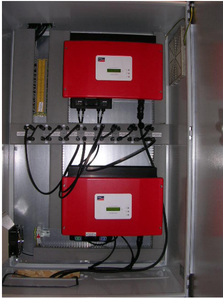
(a) Photo de l'armoire intégrant les deux onduleurs de 1100W et 1200W.
