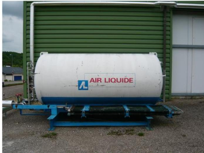
Figure I-6 : Réservoir de stockage de l'azote à basse pression (BP)
