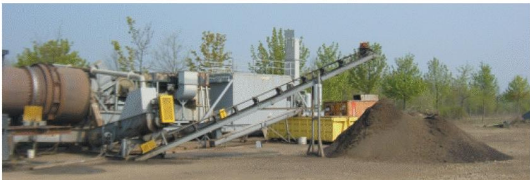
Figure 7 : Installation mobile de désorption thermique pour le traitement de sols contaminés (source DRIRE Lorraine, http://217.167.195.132/webdrire/files/DEI/Bilan02SSpollues.pdf ).
