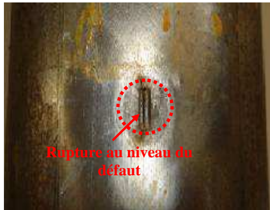
Figure III.9 : Photos de rupture du réservoir 2 (Profondeur enfoncement \approx 4\%D_e )
