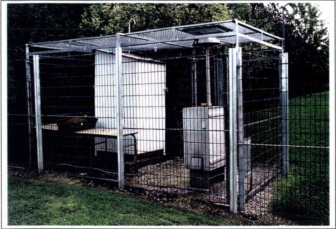
Photographie 6 : Station de Courcelles-les-Lens (photo Franck Denayer).
