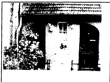
Algrange, vers 1930. Portes d'entrée sous arc surbaissé, auvent.
