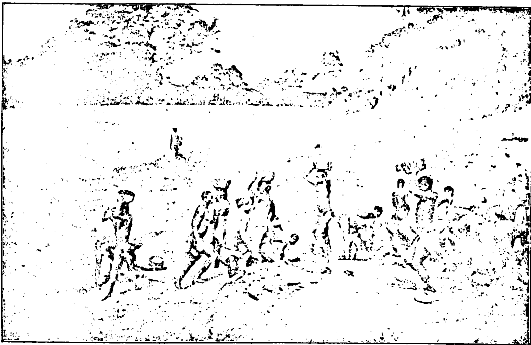
Bau einer Straße von Atakpame in das Akpoffo-Tal. Die Arbeiten werden durch Steuerarbeiter ausgeführt. Die Erdbewegung geschieht mit Körben. (Seite 22.)
