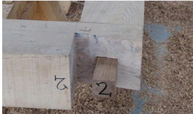
Figure 42 : Tenon bâtard de charpentier.
