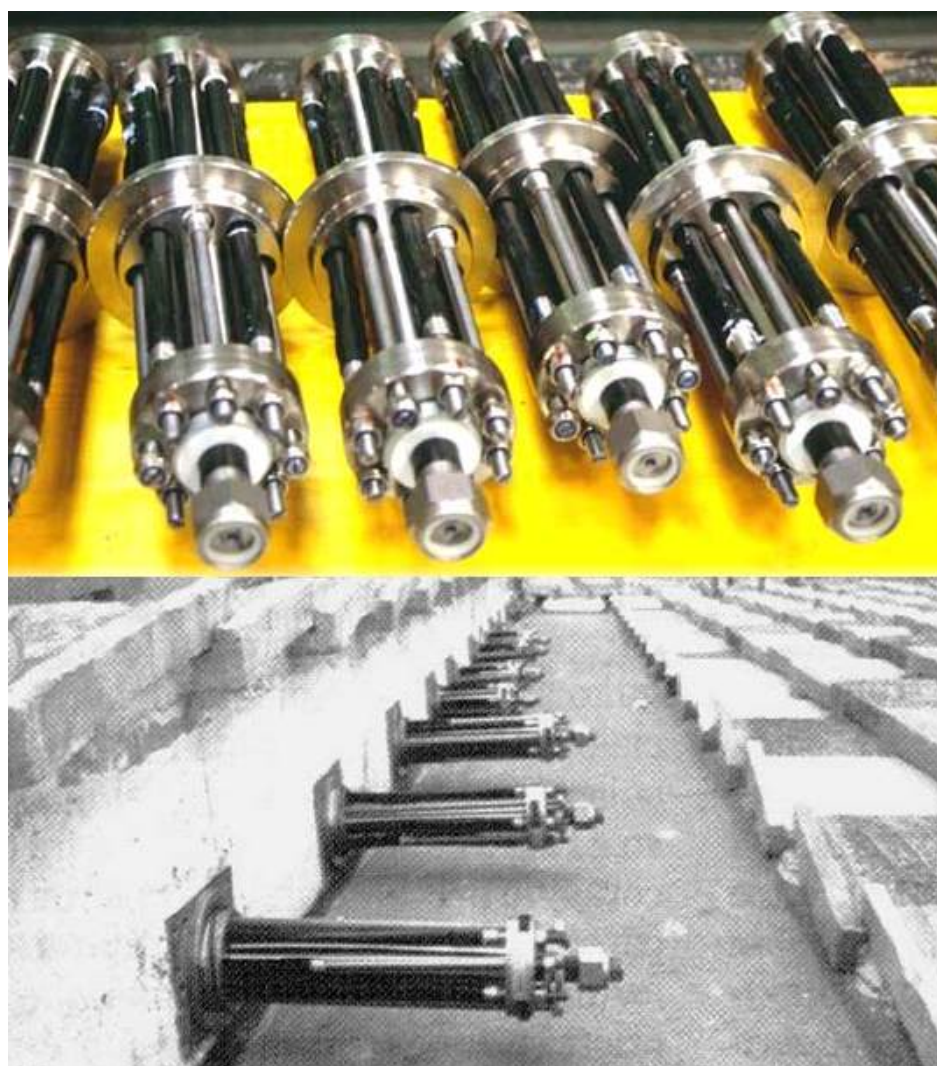
FIG. 1.9 – Renfort antisismique appliqué au tympan de la basilique Saint-François d'Assise (Castellano et al. 1999)
