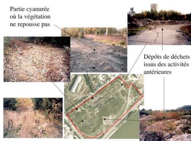
Figure 22 : Etat actuel et matériaux résiduels sur le site de Flémalle (SPAQUE, 2004).
