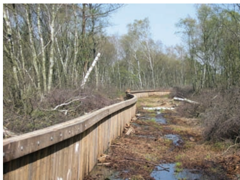
Channel siding: Plato ® Wood Norway spruce Location: Natuurgebied Korenburgerveen nabij Dwardsdijk, Winterswijk
