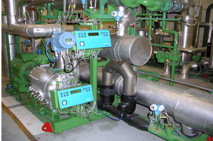
Fig. 3.72. Instalația frigorifică EDF – HP410A.
