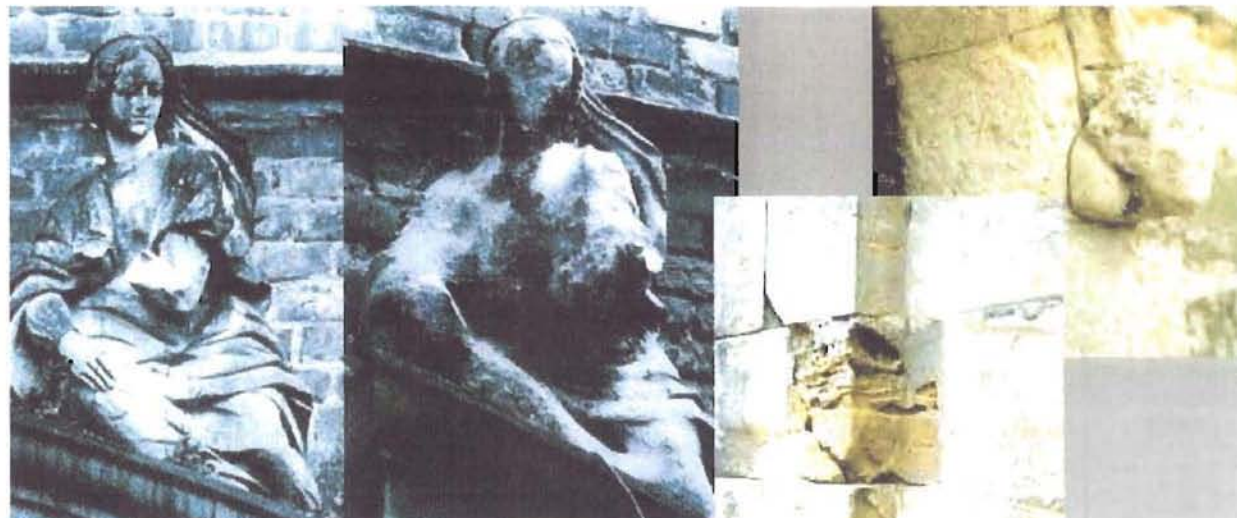
Figure 1.6 Effets des dépôts acides sur une des statues du château de Herten en Allemagne. La photo de gauche a été prise il y a 60 ans, celle au centre, il y a 5 ans.
