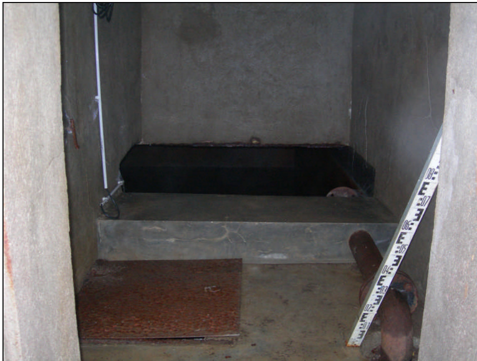
Photo a : Intérieur du local du réservoir
