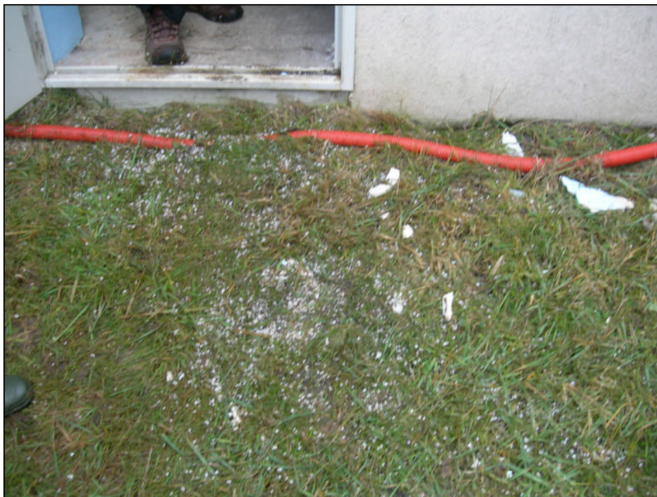
Photo b : Etat d'entretien du local béton
