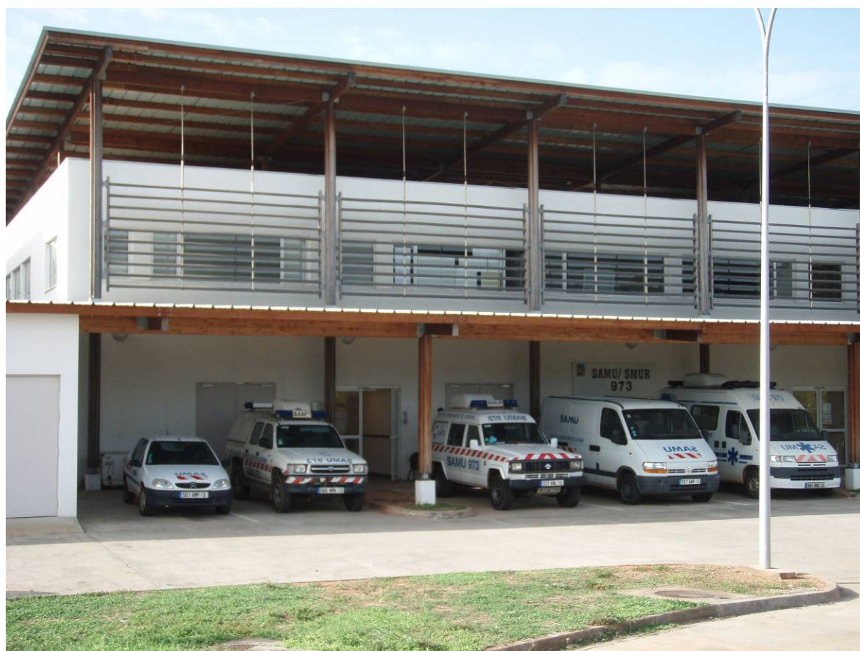
Figure 12. Locaux du SAMU 973.
