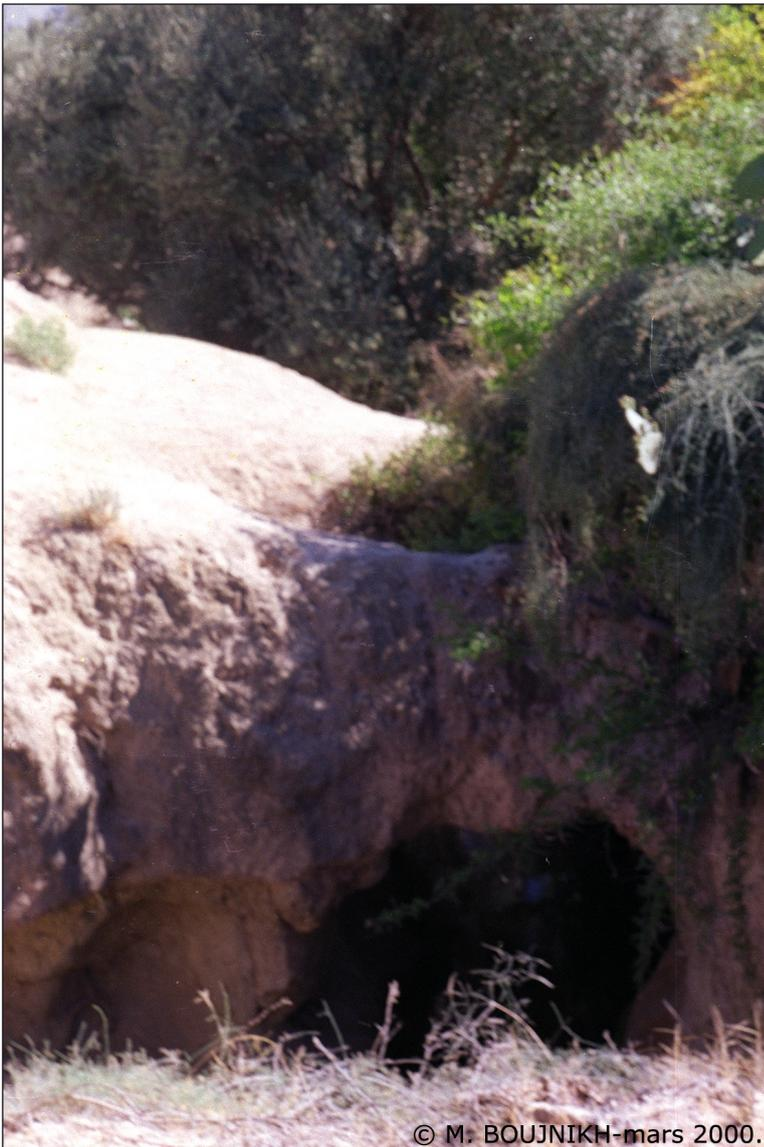
Cette photographie montre un puits *ahrike*. Ce type de puits se situe généralement à quelques mètres du débouché de la *khettara*. Son rôle est de permettre aux cureurs un accès facile à la galerie. Outre cet aspect technique, il permet aussi parfois de simplifier la récupération de l'eau à des fins domestiques. Il constitue également un endroit de détente, au fond duquel les irrigants ont plaisir à discuter au frais pendant les brûlantes journées d'été.
