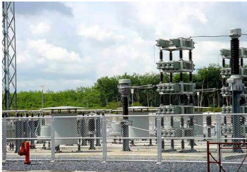
e) Filtre côté alternatif
