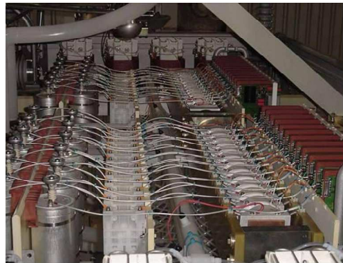
d) Valve élémentaire de 48 thyristors
