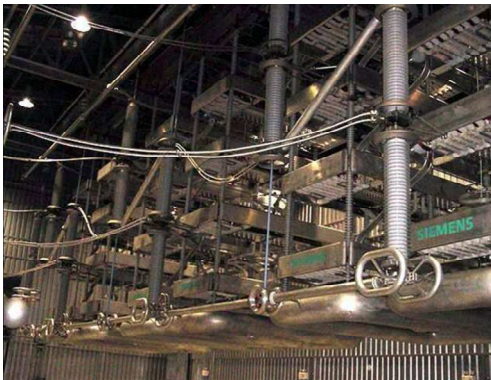
c) Section des redresseurs
