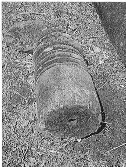
Ph. 21 : Exemple d'extrémité de balustre avec mortaise
