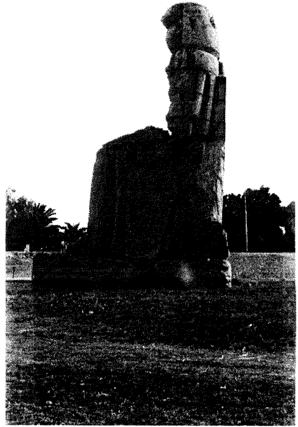
Photo 4-6. Face Nord du Colosse Nord montrant des fissures dans le socle, une large cassure dans le trône et la restauration antique en petits blocs
