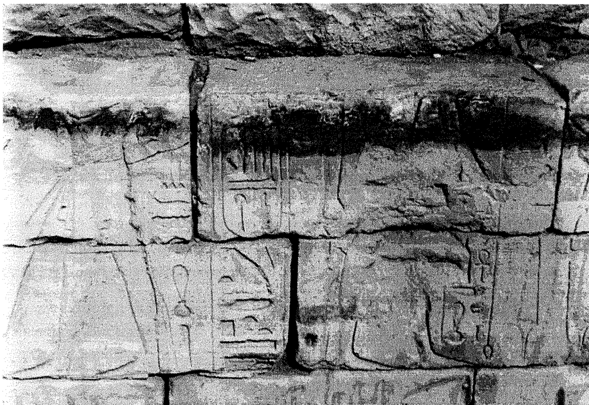
Photo 2-1. Cristallisation des sels sur le temple de Louxor
