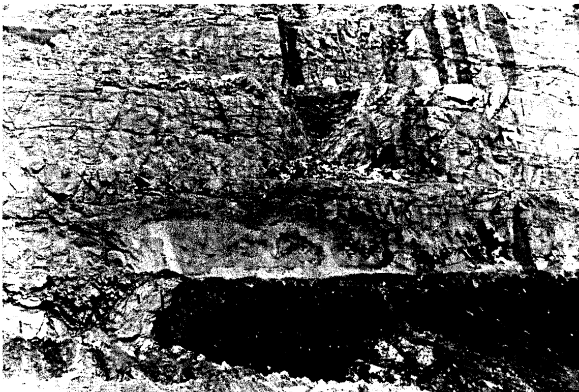
Fig. 28 : Photo du dièdre instable dans la zone B6 - B7
