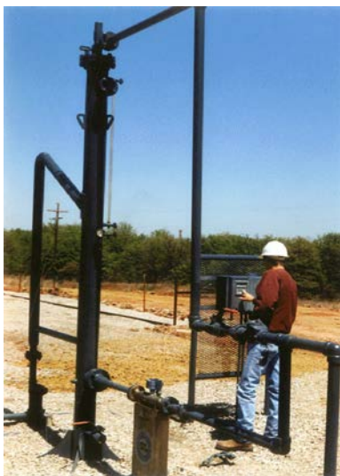
(a) Prototype installé par Chevron [Kouba1996].
