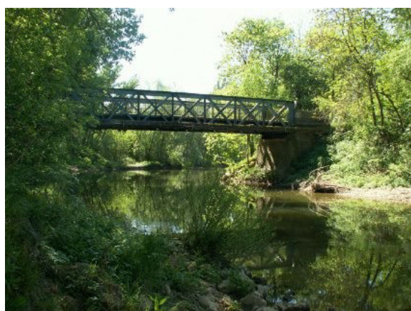
Photo 3: La passerelle à Pont-Saint-Vincent, vue de l'aval
