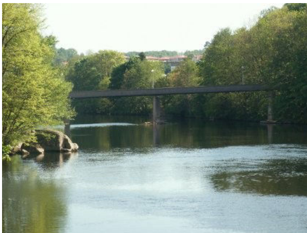
Photo 1: La passerelle des sables vue de l'amont
