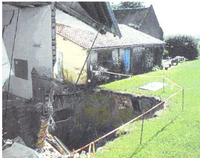
Figure 4. Exemple d'effondrement localisé (fontis) en zone pavillonnaire (source : BRGM)
