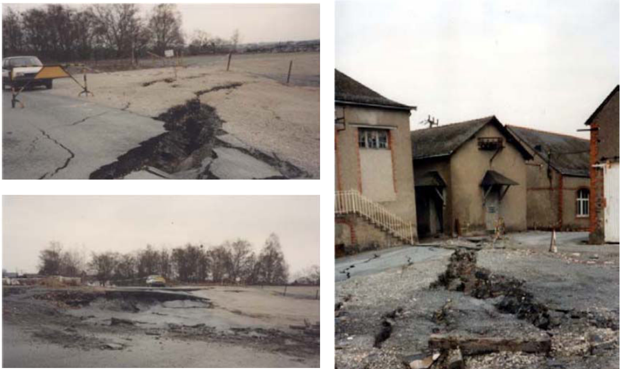
Figure 14. Effondrement brutal à la Pouéze en 1990, qui met fin à l'exploitation minière (Source : W. Zumbo, LRPC Angers)
