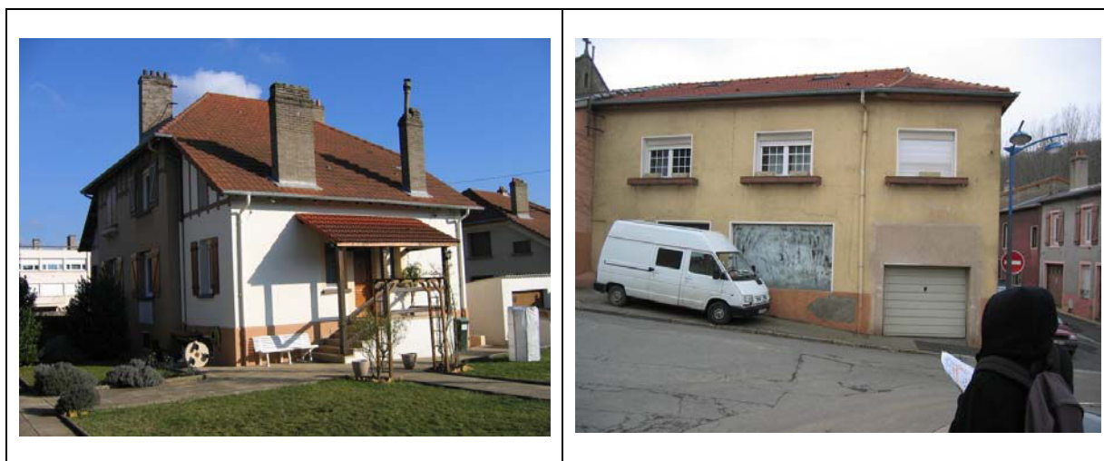
Figure 28. Exemple de maison située en terrain plat à gauche ou en pente à droite
