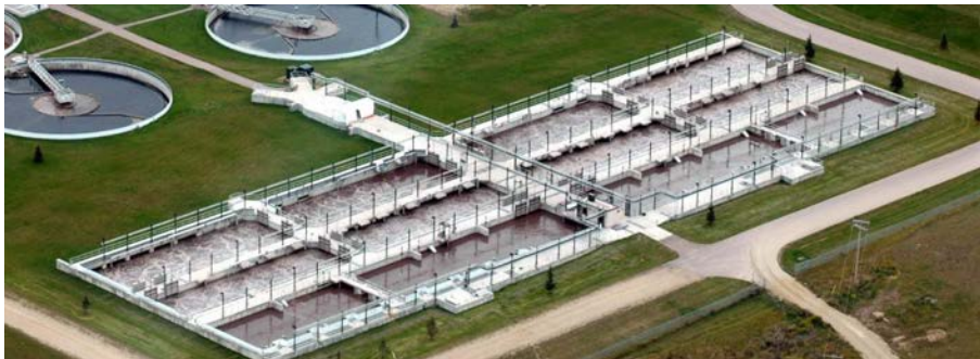
FIG. A.8 – Bassin d'aération : 1/3 anoxie et 2/3 aérobie
