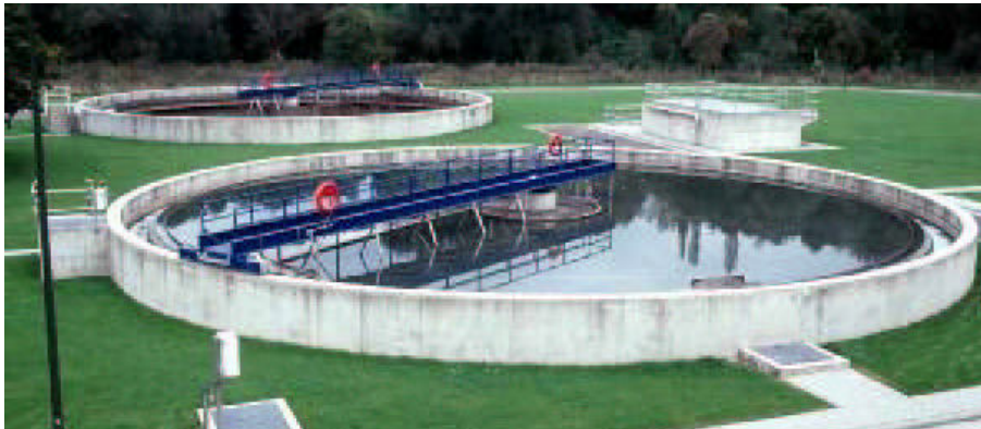
FIG. A.9 – Décanteur secondaire ou clarificateur
