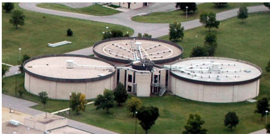
FIG. A.10 – Unité de digestion des boues
