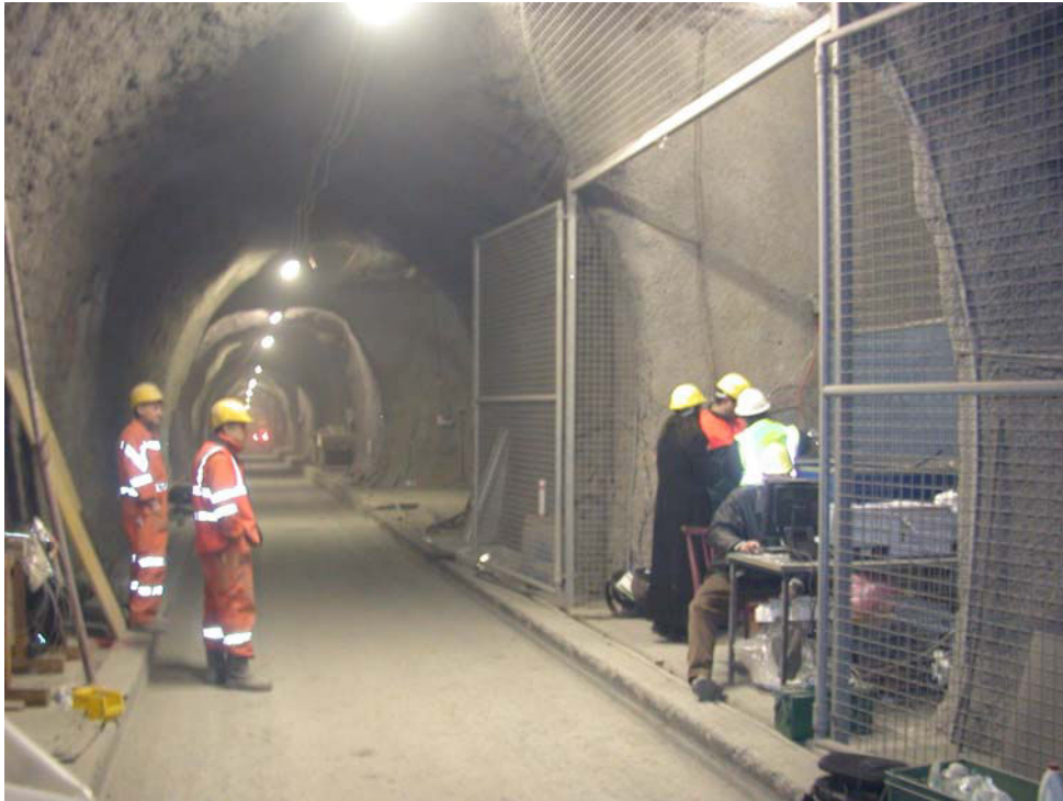
Figure 3.2 : Vue de la galerie de sécurité d'autoroute qui fait office de galerie principale du laboratoire souterrain du Mont Terri (mars 2004).
