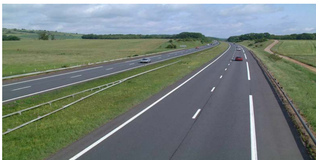
Photo 2 : Site autoroutier A31
