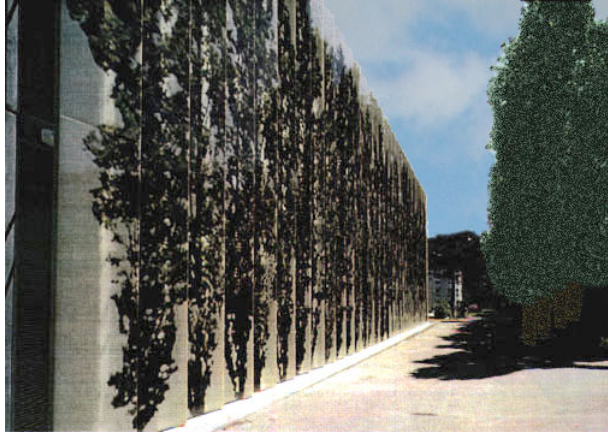
Photo N°17. A gauche, la façade en panneaux composites qui reproduit l'image de la rangée de peupliers. Ecole d'architecture et du paysage de Bordeaux. Jean de Giacinto, architecte. (document fourni par l'architecte).
