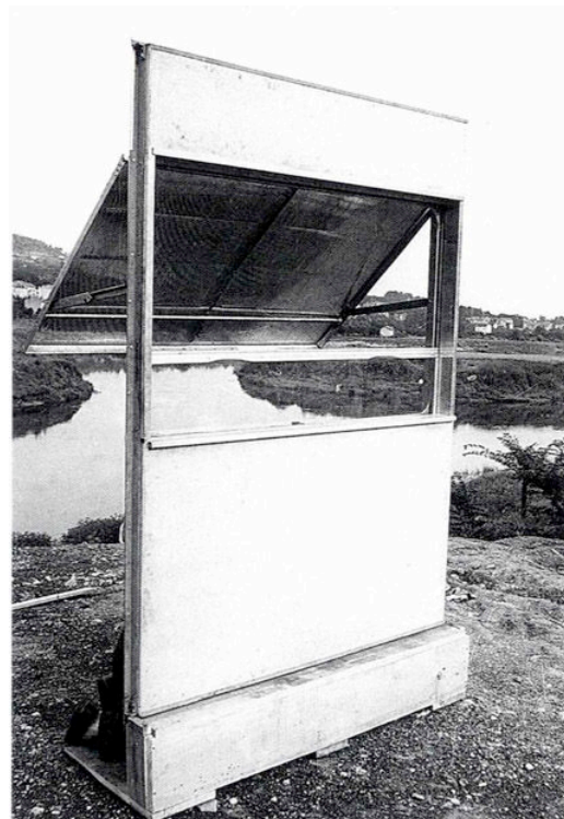
Photos 9 et 10 (annexe 16). Panneau de façade de l'immeuble d'habitation, square Mozart à Paris – 1953,1954. A droite, prototype de l'élément de façade.
