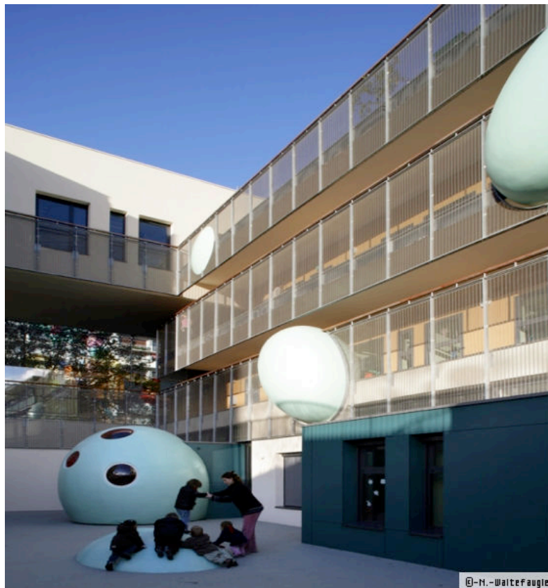
Crèche Jean Jaurès : des cabanes suspendues aux façades. P.J.A.A., architectes. Luc Boulais, conseillé sur la mise en œuvre des composites. (Document fourni par l'architecte).
