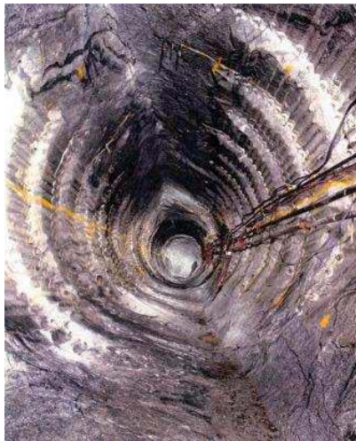
Figure 1.6 - Ecaillage en voûte et en radier et localisation des événements microsismiques et des émissions acoustiques (Read, 2004).
