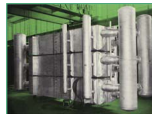
Figure I.2 - Échangeur à plaques et ondes en aluminium brasé
