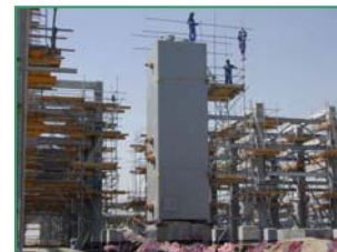
Figure I.4 - Montage sur site
