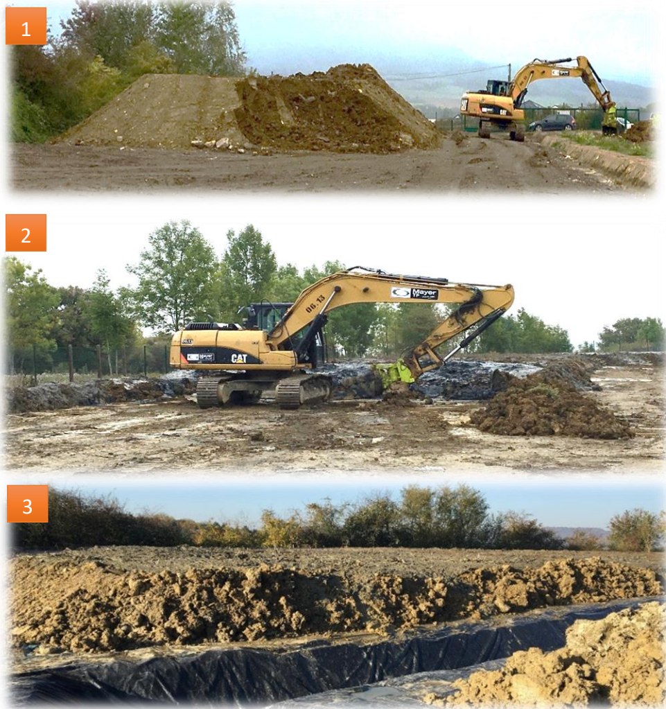
Figure 17 : Les différentes étapes de création du technosol
