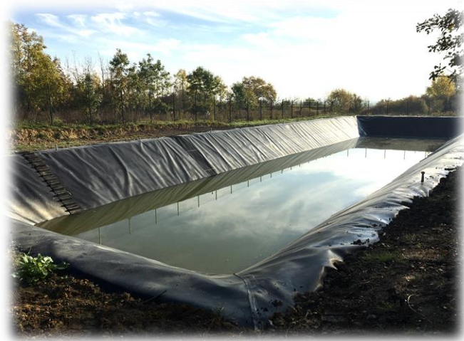
Figure 18 : Photographie du bassin de rétention en eau du site d'étude
