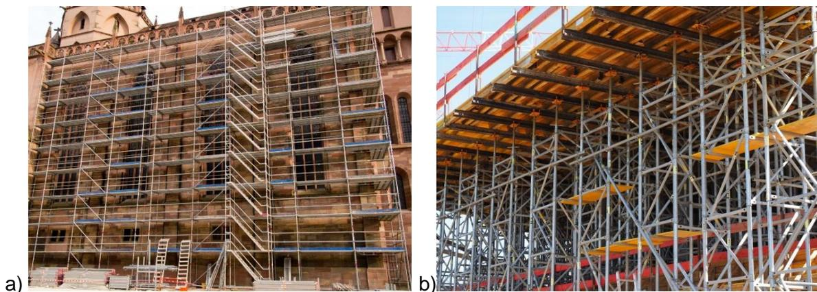
**Fig. I.1.** Équipements temporaires de chantier : a) Échafaudage de service ; b) Structure d'étalement
