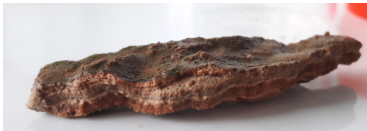
FIGURE 6.8 – Échantillon du dépôt de calcaire présent dans le regard d'entrée
