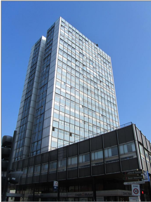
Photographie 42: Immeuble Joffre Saint Thiébaud (J.-M. Simon, mars 2015)
