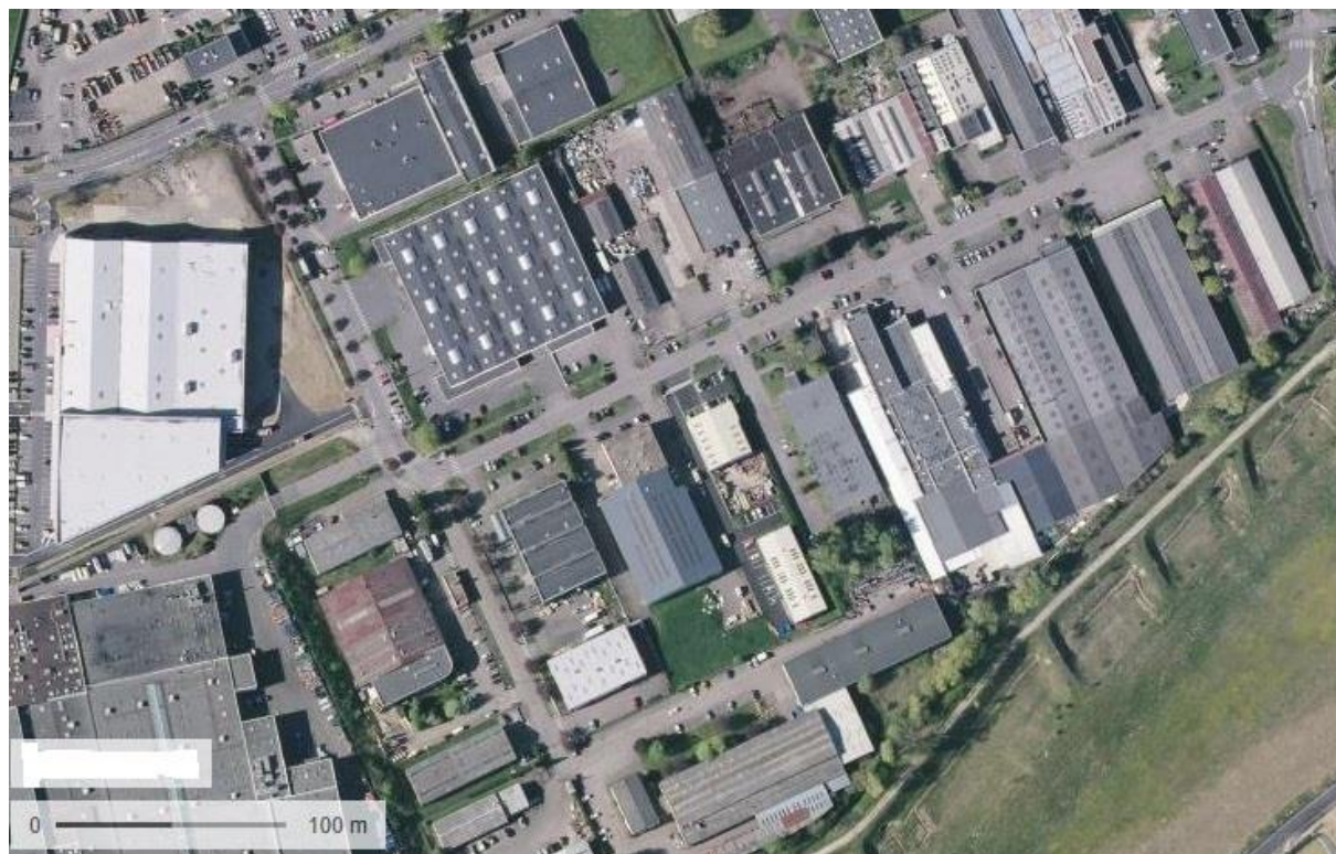
Photographie 72 : Photographie aérienne de la zone industrielle d'Heillecourt (Géoportail, février 2017).
