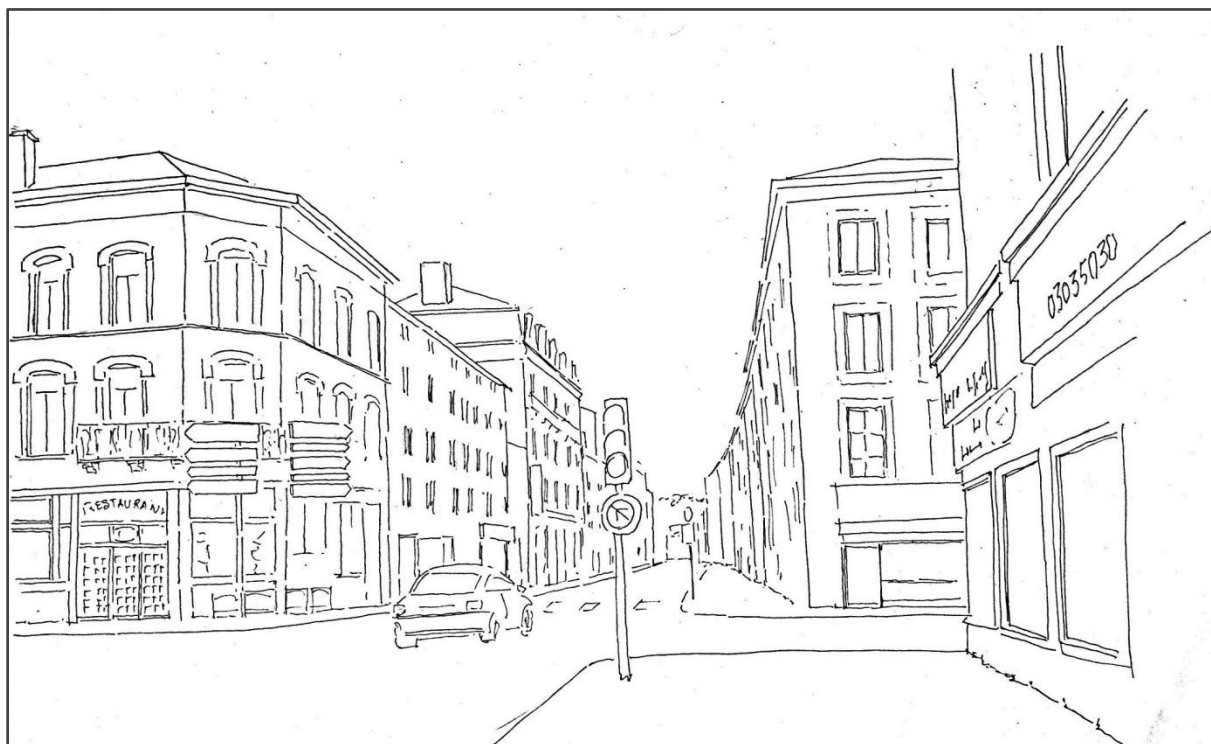
Figure 83 : Rue de l'armée Patton vue vers le nord (J.-M. Simon, septembre 2017)
