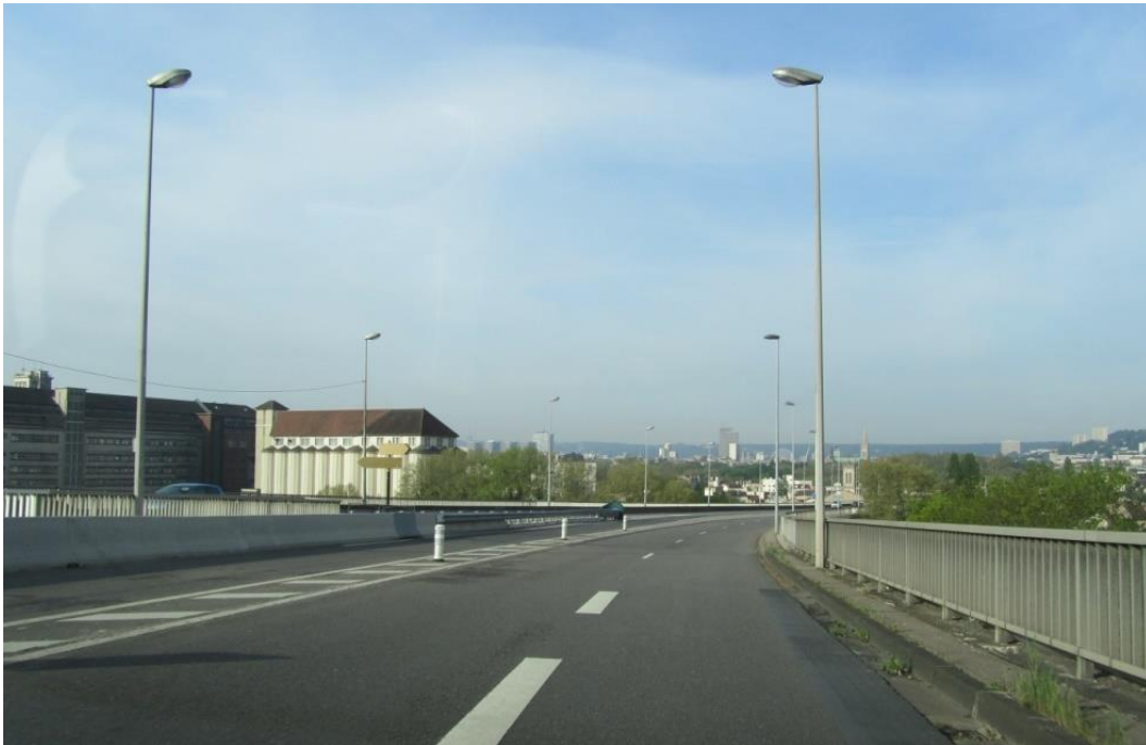
Photographie 1: Le viaduc Louis Marin, infrastructure construite en milieu urbain pour entrer dans Nancy. Le caractère est routier, mais la vitesse maximale autorisée est de 50 km/h (J.-M. Simon, juin 2016)
