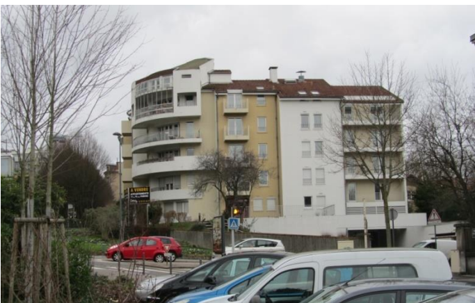
Photographie 54 : À l'est, immeuble des années 1970 (J.-M. Simon, janvier 2017)
