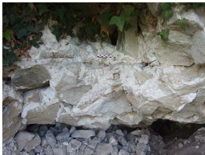
Fig. 7 – Niveau de réglage dans le blocage marqué par le contact de deux mortiers issus d'une pose décalée, donjon de Fontenoy-le-Château, 88 (cliché Cédric Moulis).
