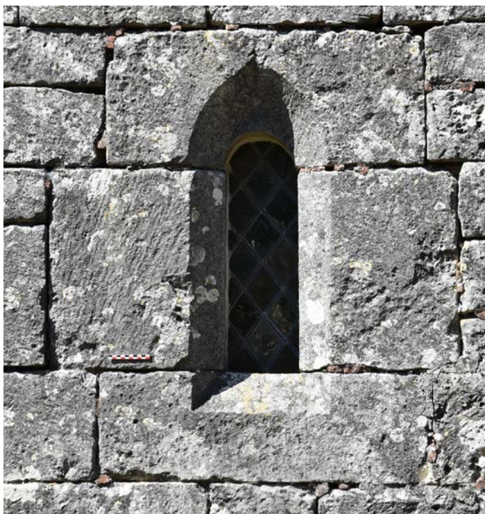
Fig. 20 – Fenêtre trapue à arc brisé, mur gouttereau de l'église de Saudron, 52 (cliché Cédric Moulis).
