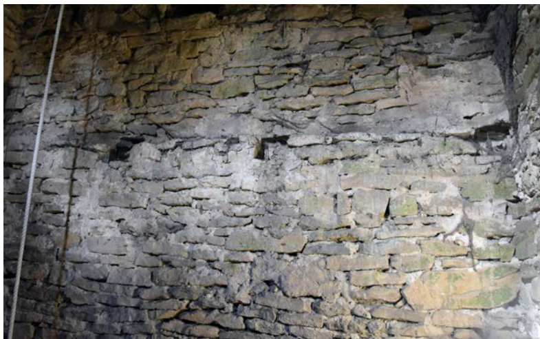
Fig. 57 – Empochements des poutres supportant le plancher d'un étage initial du clocher de Ville-sur-Illon, 88 (cliché Cédric Moulis).
