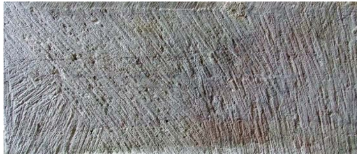
Fig. 20 – Layage dans la crypte d'Esley, 88. On remarque une ciselure sur la partie supérieure gauche de la photo (cliché Cédric Moulis).
