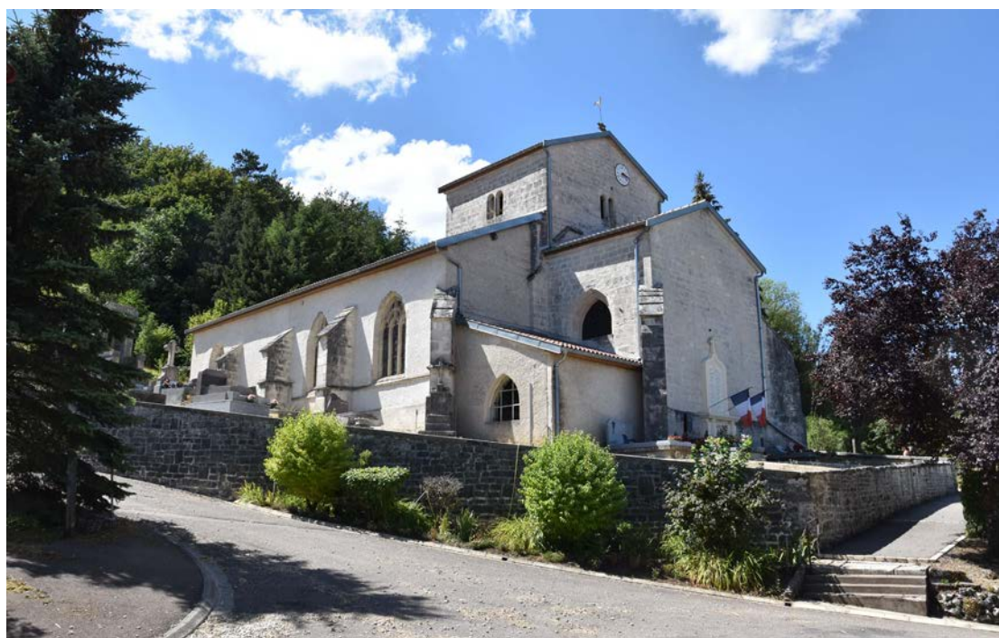
Fig. 6 – L'église d'Effincourt, (52, XII e siècle), située à mi-pente du coteau dominant la Saulx (cliché Cédric Moulis).
