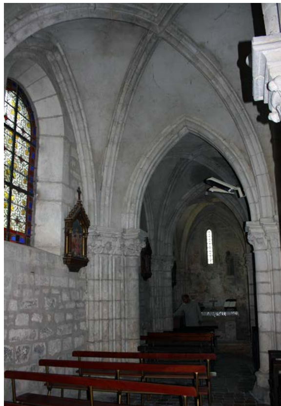
Fig. 11 – Croisée d'ogives à nervures moulurées, bas-côté de l'église d'Écrouves, 54 (cliché Marion Subts).
