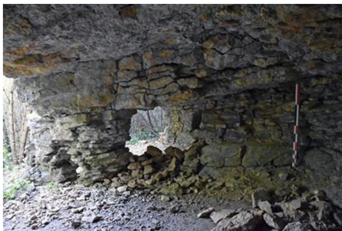
Fig. 7 – Délitage naturel de la carrière d'extraction semi-enfouie, dite grotte des Chambrettes, colline de Sion (cliché Cédric Moulis).
