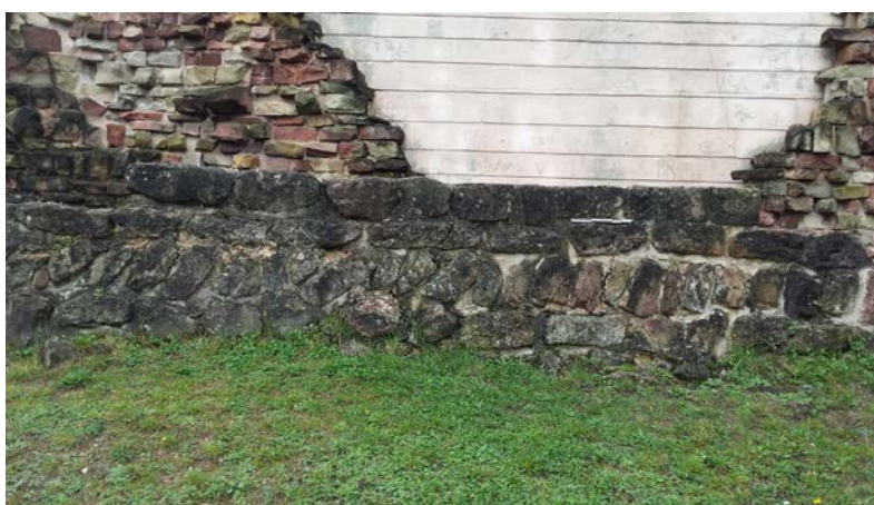
Fig. 49 – Assise en épi sur une structure précoce du château d'Épinal, 88 (cliché Cédric Moulis).
