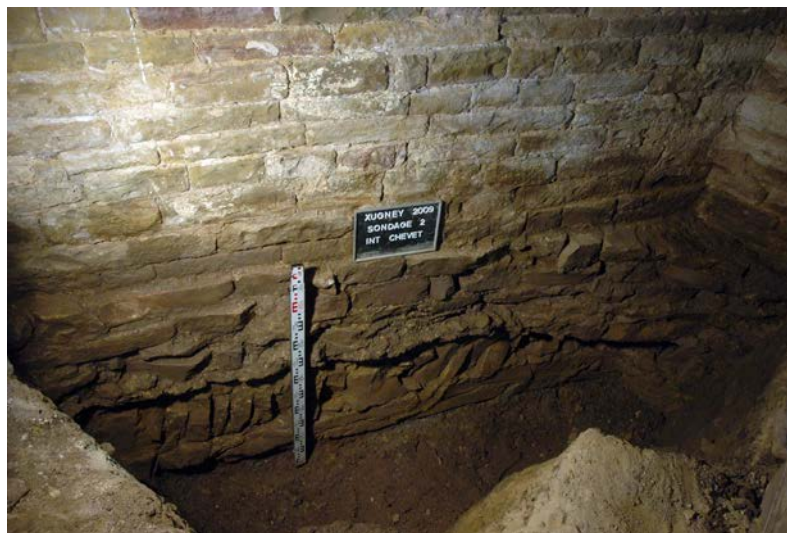
Fig. 48 – Fondations du chevet de la chapelle de Xugney, 88 (cliché Cédric Moulis).
