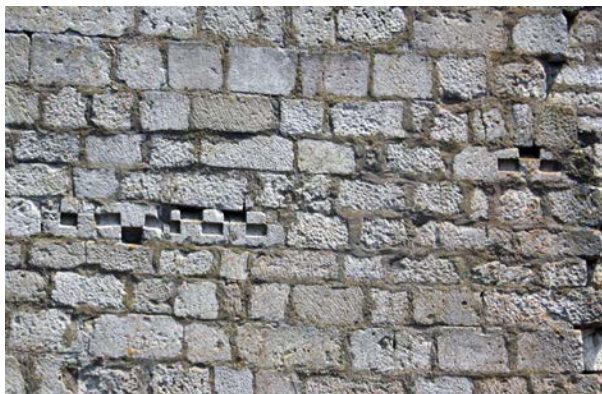
Fig. 41 – Fragments de corniche décorée de billettes romanes en remploi dans la reprise du clocher de Barisey-la-Côte, 54 (cliché Marion Subts).
