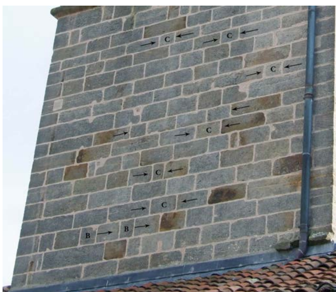
Fig. 32 – Boutisses décalantes (B) et clefs d'assises (C) avec le sens de pose des assises sur le clocher d'Isches, 88 (cliché et conception Cédric Moulis).
