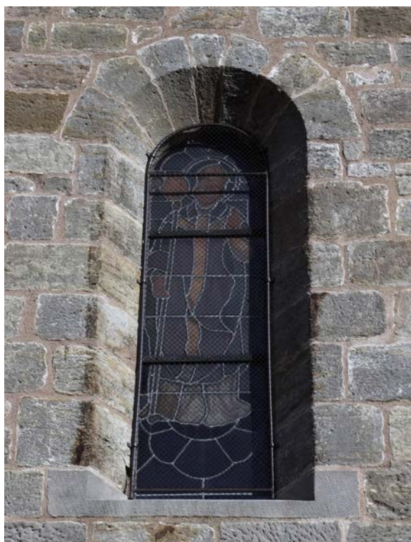
Fig. 25 – Arc composé de sept voussoirs, avec une clef d'arc de module inférieur, église d'Isches, 88 (cliché Cédric Moulis).
