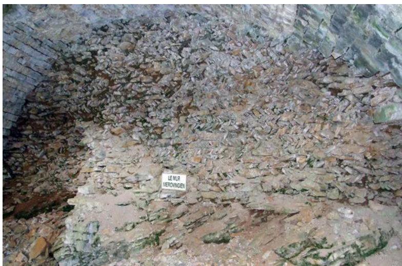
Fig. 55 – Structure en épi dans le château d'Arlay (39), de même nature que celle à Vaudémont (cliché Cédric Moulis).
