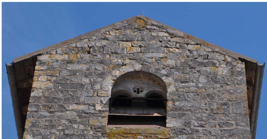
Fig. 12 – La toiture en bâtière du clocher de Puxe-Laloeuf (54) est un rehaussement postérieur, réalisé par des pierres de remploi, notamment des éléments de décor en zigzag (cliché Cédric Moulis).
