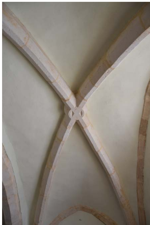
Fig. 13 – Croisée d'ogives à nervures prismatiques, chœur de l'église de Vroncourt-sur-Meuse, 52 (cliché Cédric Moulis).
