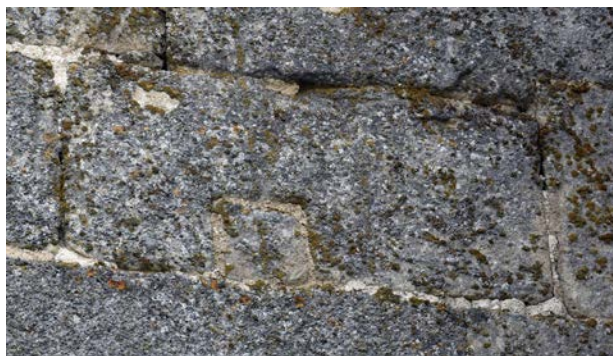
Fig. 21 – Trou de boulín façonné d'arête, bouché correctement dès la fin de son utilisation, église de Nançois-le-Grand, 55 (cliché Cédric Moulis).
