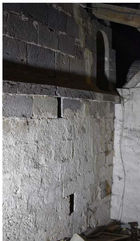
Fig. 4 – Trous de boulin maçonnés de forme rectangulaire, mur gouttereau de la nef de Gelvécourt-et-Adompt, 88 (cliché Cédric Moulis).
