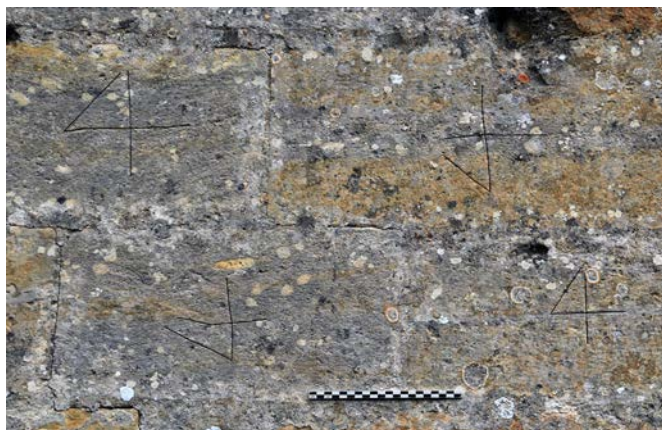
Fig. 3 – Signes lapidaires XV sur le parement de l'église de Couvonges, 55 (cliché Cédric Moulis).
