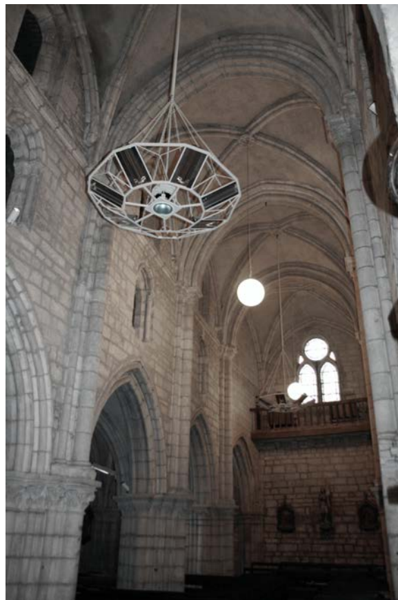
Fig. 19 – Arcs doubleaux et formerets brisés, nef d'Écrouves, 54 (cliché Marion Subts).
