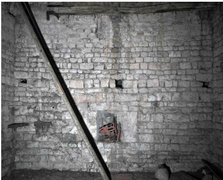
Fig. 35 – Paveint intérieur bien assisé, premier étage du clocher de Blénod-lès-Pont-à-Mousson, 54 (cliché Cédric Moulis).
