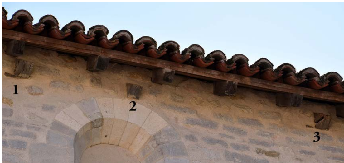
Fig. 2 – Trois entrails romans visibles sur le gouttereau nord de l'église de Coussey, 88 (cliché Cédric Moulis).
