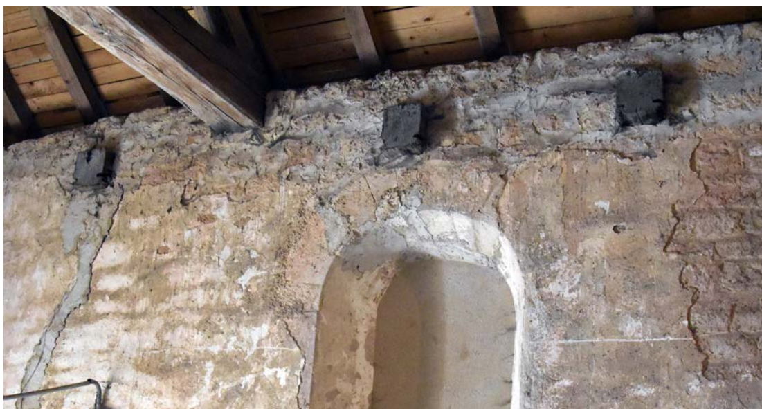
Fig. 4 – Les trois fragments d'entrails sciés vus depuis les combles de l'église de Coussey (cliché Cédric Moulis).
