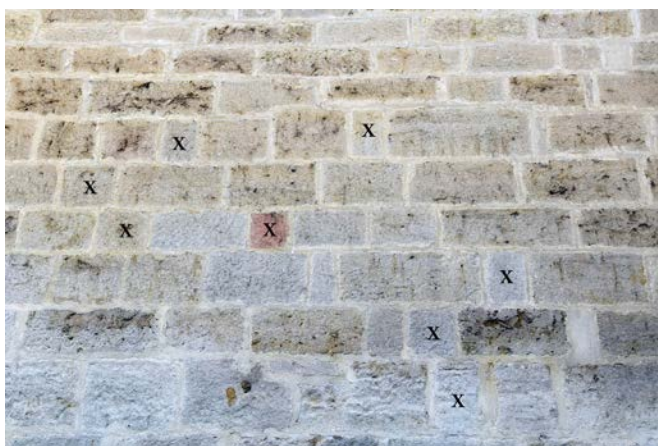
Fig. 31 – Le parement de l'église d'Andilly (54) présente des pierres qui sont potentiellement des boutisses (cliché Marion Subts).
