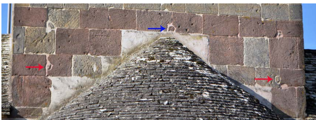
Fig. 8 – Trous de boulin façonné sur arête verticale (flèches rouges), et un trou façonné dichotomique d'angle (flèche bleue), clocher de l'église de Gorhey, 88 (cliché Cédric Moulis).
