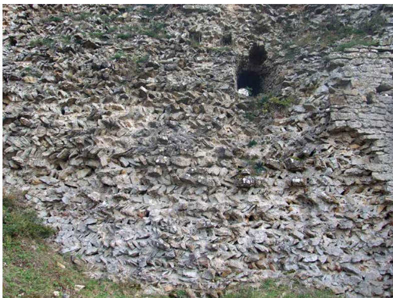
Fig. 54 – Blocage en épi du donjon de Vaudémont, 54 (cliché Cédric Moulis).
