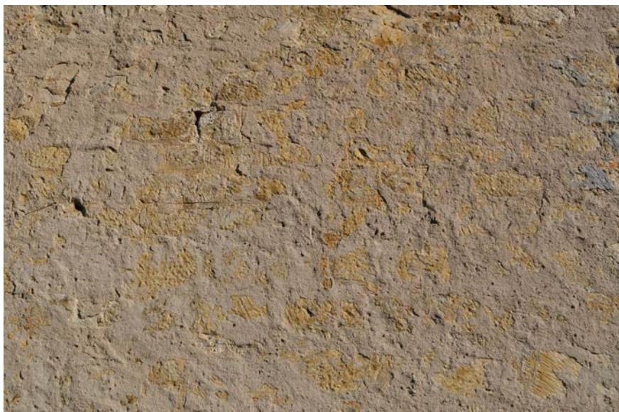
Fig. 21 – Enduit moderne granuleux posé sur l'enduit de faux joints primitif de l'église de Vandelévillle, 54 (cliché Cédric Moulis).
