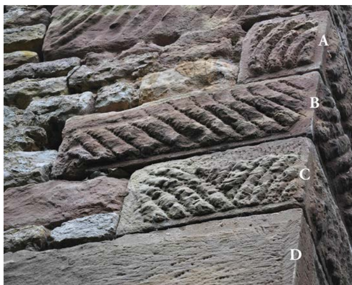
Fig. 17 – La chaîne d'angle du château de Romont (88) montre bien le recul du travail de taille plus on monte dans l'élevation. Cela permet de dérouler dans l'ordre chronologique les différentes étapes de la taille de ces pierres, de A à D (cliché Cédric Moulis).
