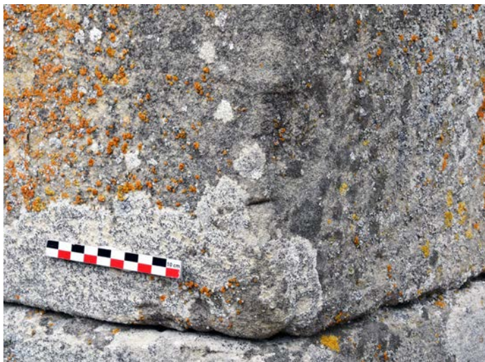
Fig. 30 – Trace d'une emboîture avec trois marques de broche sur l'arête verticale d'une pierre d'angle de la façade de l'abbaye de Haute-Seille (cliché Cédric Moulis).
