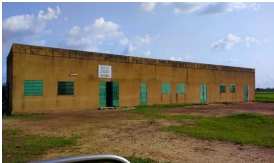
Photo 115 : Trois anciennes classes réhabilitées en 1991, 1993 et 2003 et servant désormais de magasins et ateliers pour la fabrication du beurre de karité et de la farine de blé par les femmes du village de Loaga.
