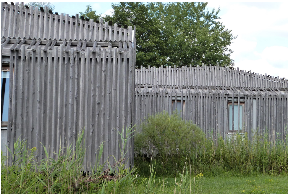
FIGURE 1.22 – Grisaillement uniforme sur des gîtes à Celles-sur-plaine (Vosges) (Agence Cartignies-Canonica)
