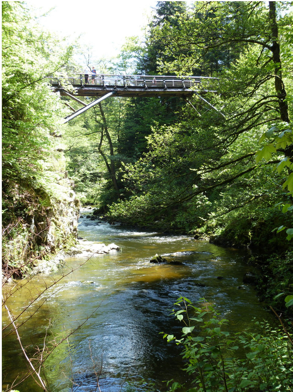
FIGURE 2.1 – Vue générale de la passerelle des gorges de Crosery
