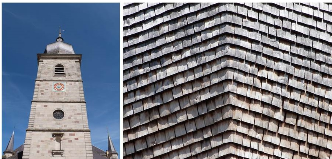
FIGURE 2.3 – Vue globale du clocher de Remiremont (Vosges) et détail des taillans composant sa toiture
