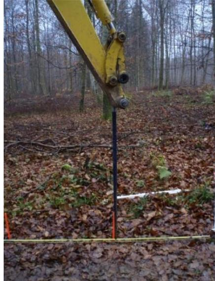
Photographie 14 – Sondage à la pelleuse en vue la détermination de la profondeur d'apparition de la roche-mère calcaire (site expérimental de Montiers).
