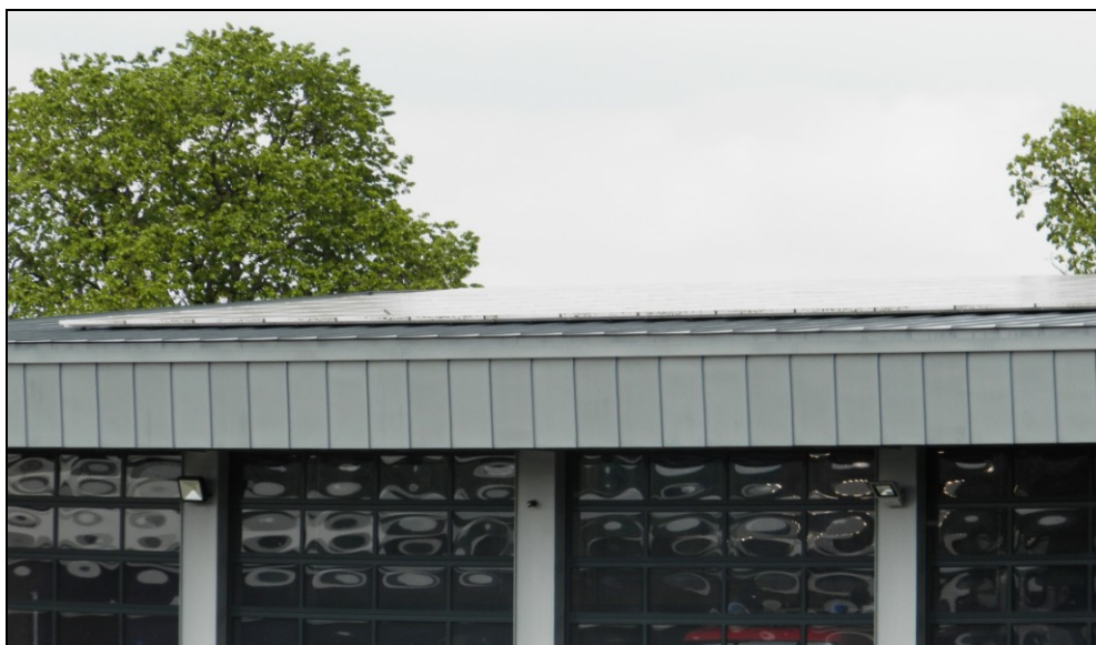
Photographie 24 : Un exemple de sensibilisation à la transition énergétique avec la présence de panneaux solaires sur la caserne de Beckerich
