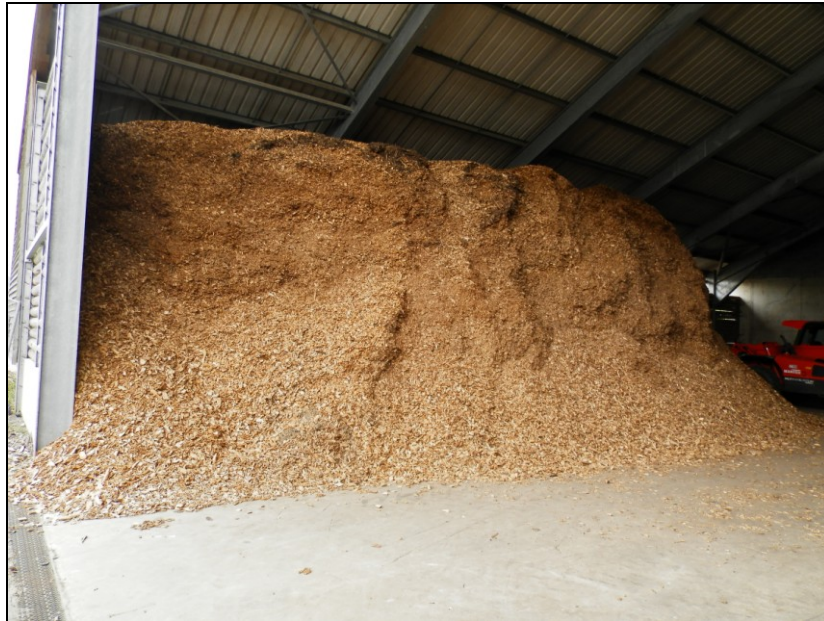
Photographies 36, 37 et 38 : La chaudière à copeaux de bois d'Hovelange (Beckerich)
