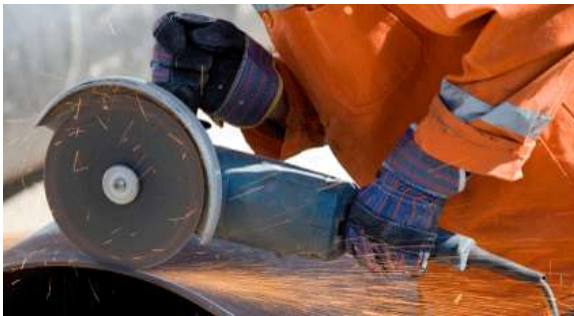
Figure 4.1 Travailleur utilisant une meuleuse
