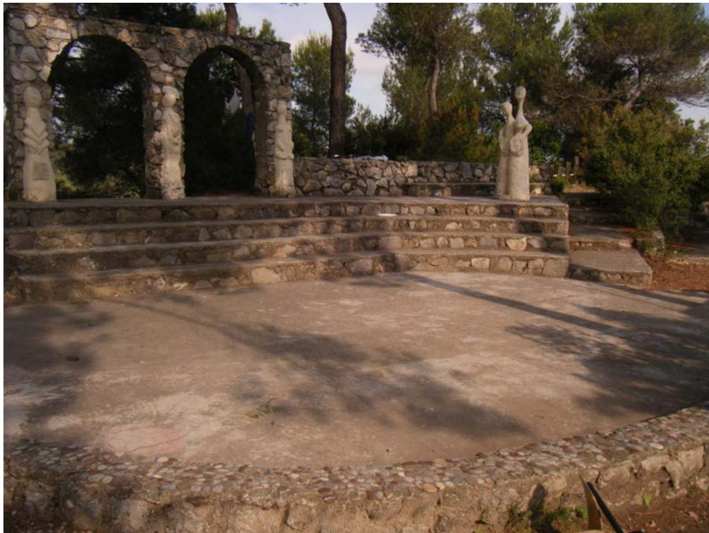
Photo. 1.13 – Vue du Théâtre : au premier plan le petit muret, puis la dalle de ciment ; au second plan les marches gradin ou scène, les arches et leurs bas-reliefs, une statue. On remarquera tout à droite de l'image le petit réduit caché derrière des buissons, pouvant servir la mise en scène.
