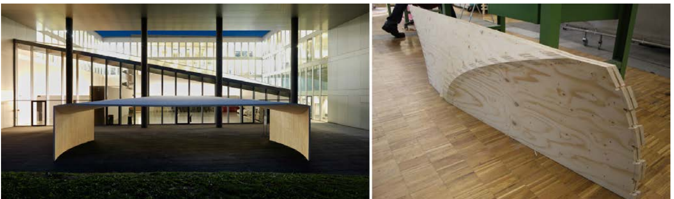
Figure 2.24 - Prototype formé de panneaux de CLT incurvés et assemblés par un système de queues d'aronde. L'ensemble des panneaux a été usiné par une machine à commande numérique. D'après (Robeller et al., 2014).
