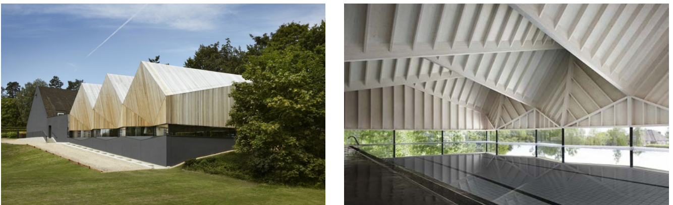
Figure 2.28 - Vue extérieure et vue intérieure de la piscine d'Alfriston School. La morphologie du plissage ainsi que les montants visibles des composants favorisent l'absorption du son. D'après (Hobhouse, 2015).
