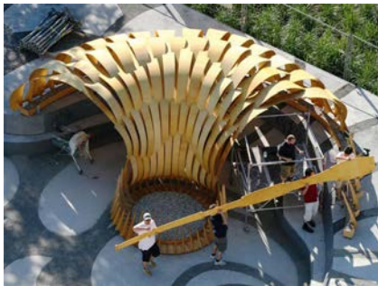
Figure 2.25 - Montage du pavillon ICD/ITKE 2010. Chaque bande de contreplaqué est maintenue par la précédente. Source ICD/ITKE, Stuttgart, 2010.
