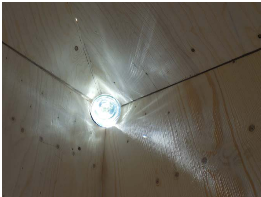
Figure 6.23 - Diffusion de la lumière par les nœuds à l'intérieur de l'enveloppe plissée (perçement comblé par une bouteille de verre remplie d'eau). Détail de la New-Yourte, Défis du bois 2014.
